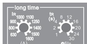
Пороговое значение тока срабатывания защиты от перегрузки с длительной выдержкой времени:
