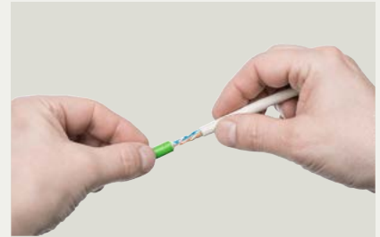
Удалите оплетку и снимите витой экран
