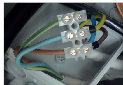
Рис. 7: Здесь N и PE были взаимозаменяемы
