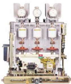
Двустабильный приводной механизм
